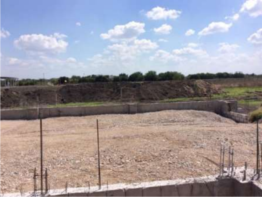
Obra en proceso del campus Tamuín.
