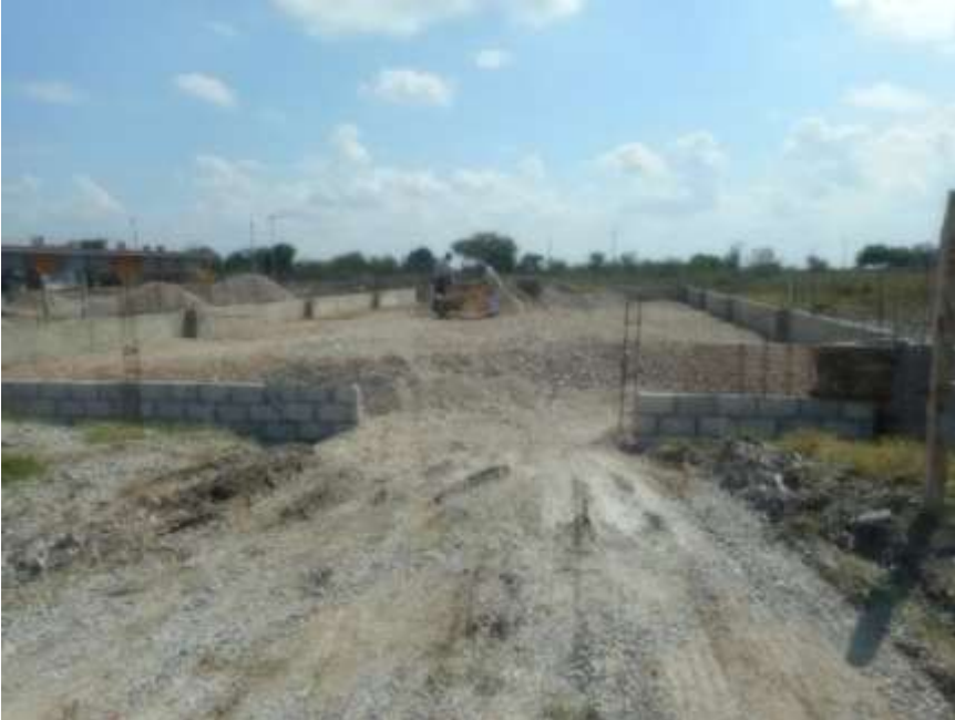
Obra en proceso del campus Tamuín.
