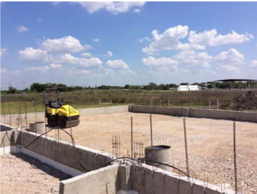
Obra en proceso del campus Tamuín.
