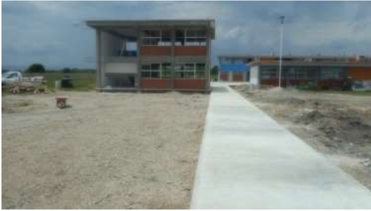
Obra en proceso el campus Tamuín.
