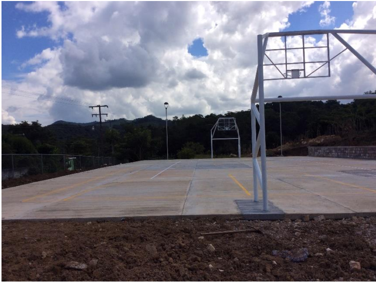
Obra en proceso el campus Tamazunchale.
