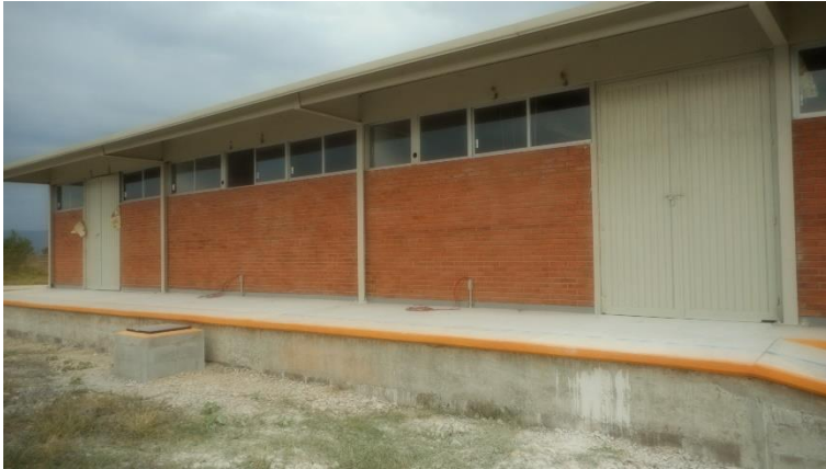
Obra en proceso el campus Tamuín.
