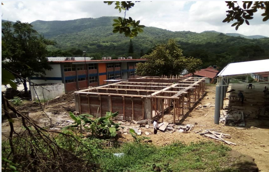
Obra en proceso FAM 2020, archivo
