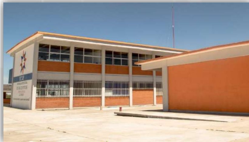
Fig. Instalaciones Villa de Reyes.
