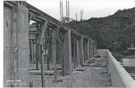
Azotea del Edificio D
